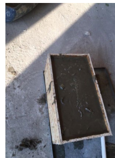
Рисунок 6 – Загрузка бетонной смеси
